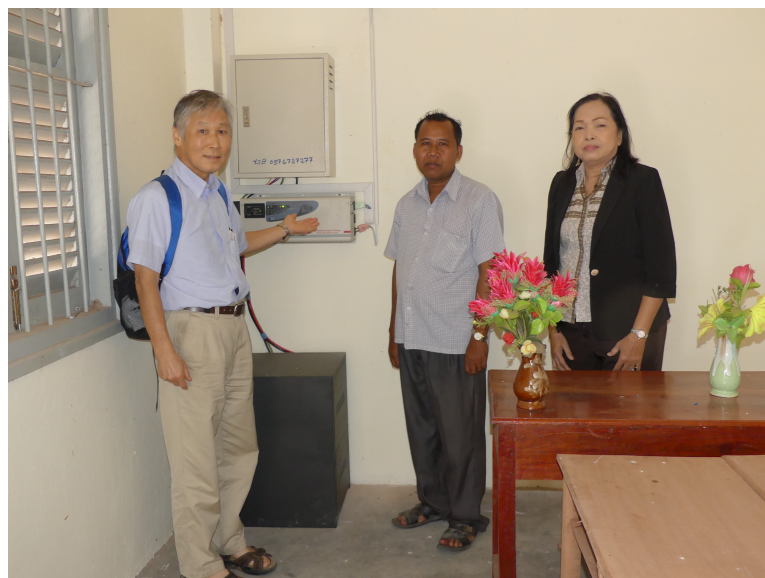
上：教室内に設置したインバーター、 コントローラー、蓄電池
