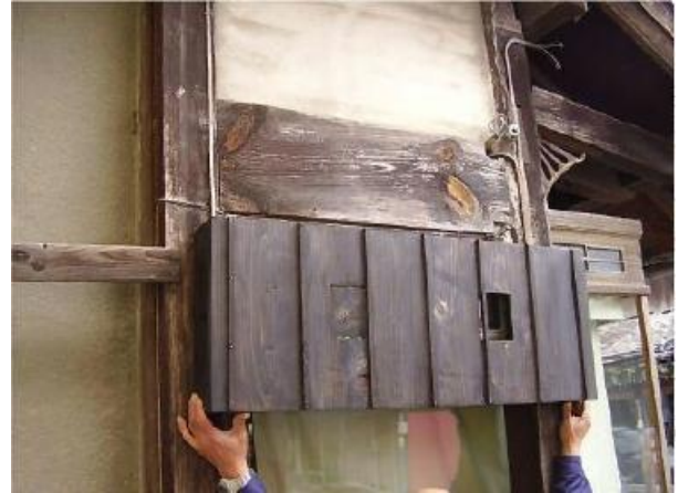
メーター器目隠し取付
