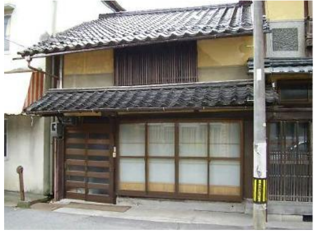
格子取付け後の町家
