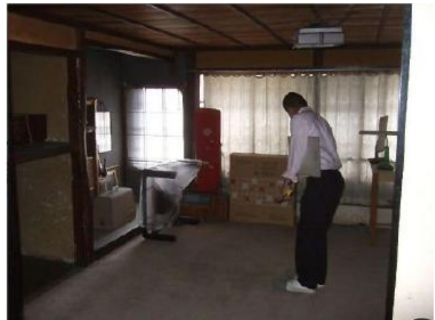
内部詳細調査
