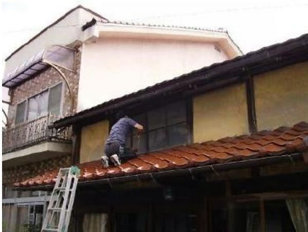
木格子取付箇所の寸法取り風景です。 当家以外に本年度2軒を寸法取りし取付ました。 他に1軒は室外機の目隠し製作取付。
