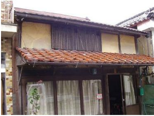
格子取付け後の町家
