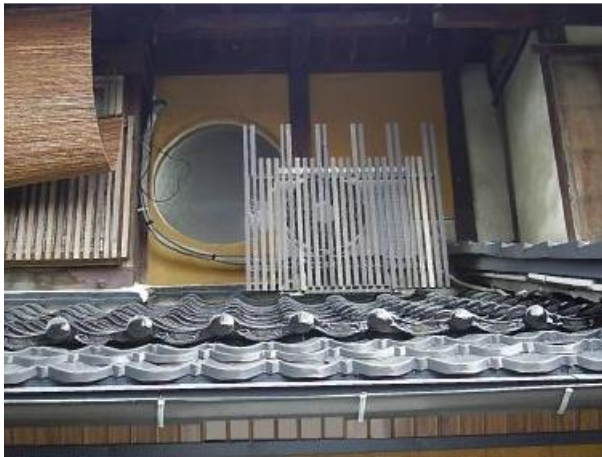
室外機目隠し格子取付け
