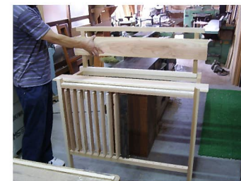
・エアコン目隠し木格子ルーバー製作設置（町並み修景）
