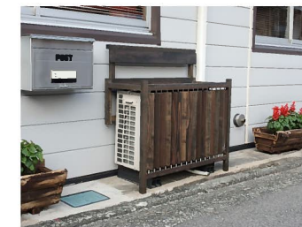
・エアコン目隠し木格子ルーバー製作設置（町並み修景）
