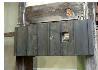
メーター器目隠し
