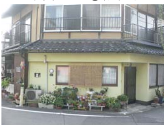
写真 24 ②設置状況
