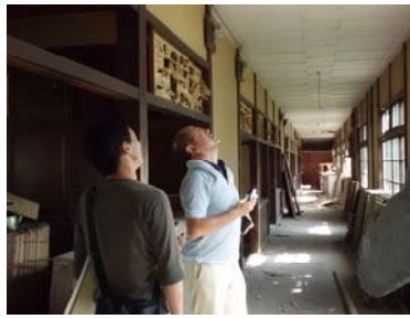
写真 30 建物内部調査
