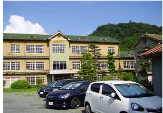
写真 28 活用対象建物の一部
