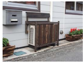
写真 23 ①設置状況
